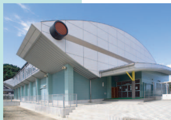
▲豊間中学校体育館
