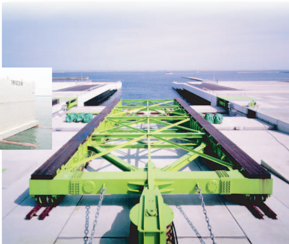
▲小名浜港県有ケーソンヤード
