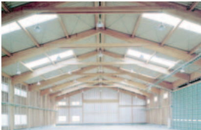
▲木質大断面施工（いわきプレカット協同組合）
